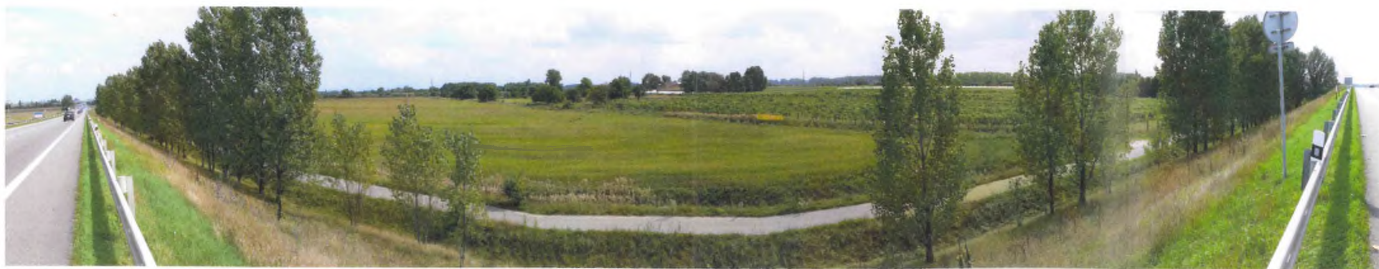
Foto č.2: Jižní část posuzované plochy
